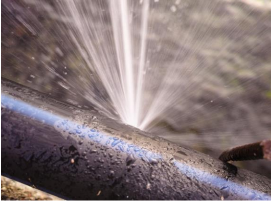
Leak detection (DAS,DTS)
